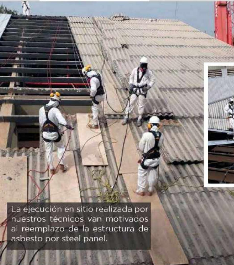
La ejecución en sitio realizada por nuestros técnicos van motivados al reemplazo de la estructura de asbesto por steel panel.
